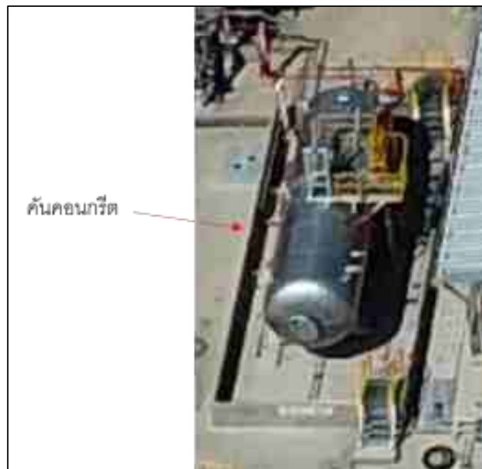
รูปที่ 2.4-6 ตัวอย่างคั่นคอนกรีตรองรับการรั่วไหล
