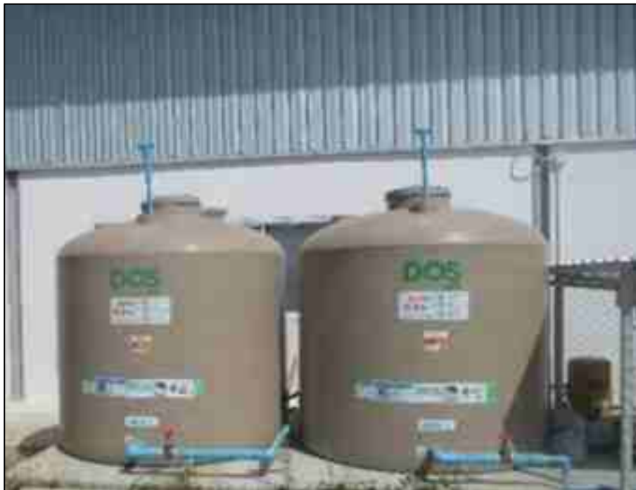
รูปที่ 2.5-2 รูปตัวอย่างการติดตั้งถังน้ำสำรอง
